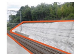
線路の法面補強
