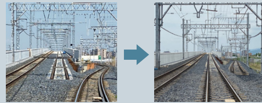
下り線高架切替え前 下り線高架切替え後
