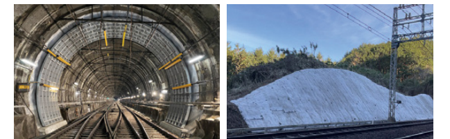
難波線シールドトンネル耐震補強工事
