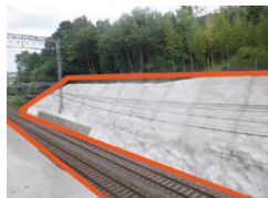
線路の法面補強
