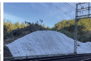
法面補強工事(大阪線)
