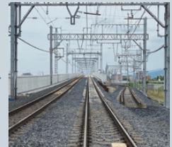
下り線高架切替え後
