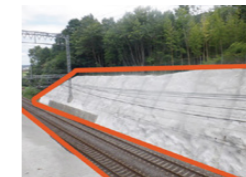
線路の法面補強
