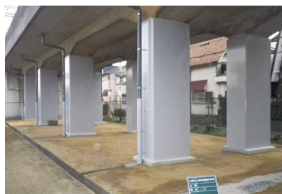
耐震補強工事
