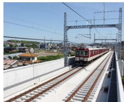
長野線喜志・富田林間 立体交差化工事
