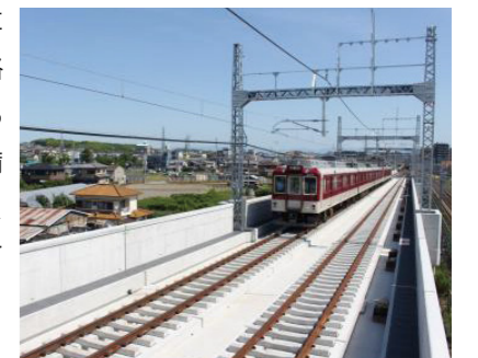
長野線喜志・富田林間 立体交差化工事
