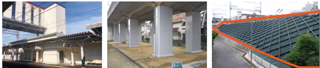
バリアフリー化(エレベーター設置)
