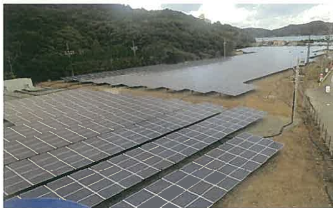
【近鉄池の浦ソーラー発電所 現場写真】
