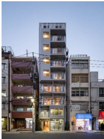
【「REFIO浅草橋」外観】
