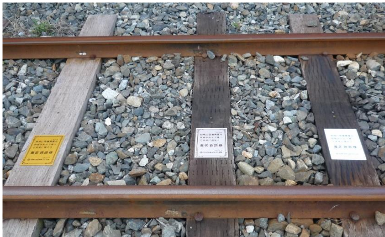
オーナープレート設置状態
