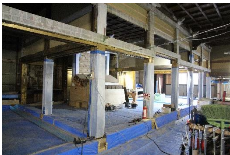
称念寺本堂（内部造作施工中）
