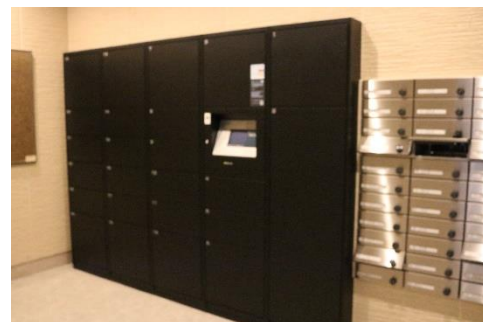
【宅配ロッカー】
