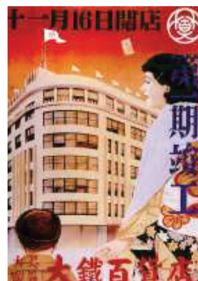
大鉄百貨店 第一期全館開業時 ポスター
